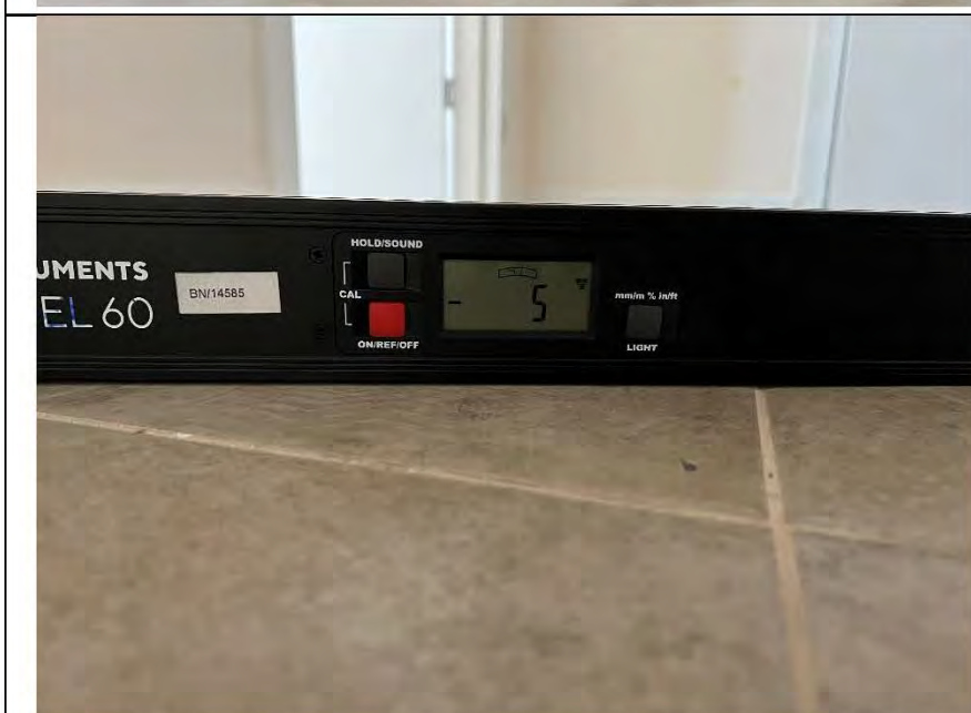
Фото №24. Измерение уровня напольного покрытия в коридоре.
