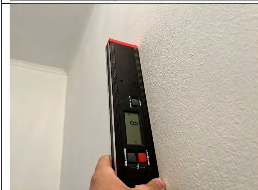
Фото №21. Измерение уровня стен в ванной комнате.
