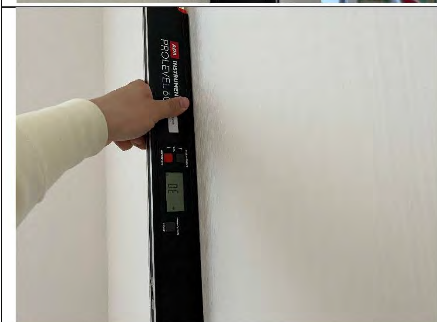
Фото №12. Измерение уровня стен в спальне.
