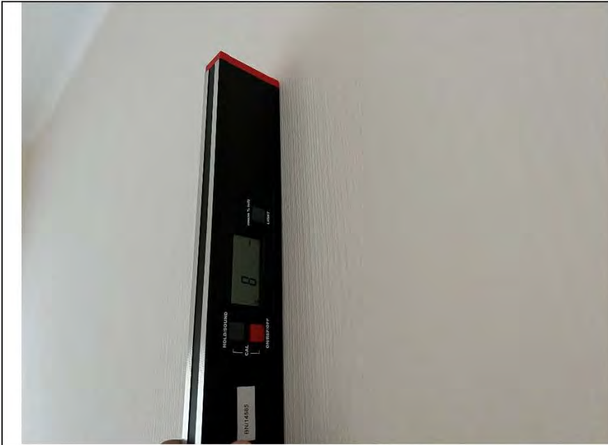
Фото №10. Измерение уровня стен в коридоре.
