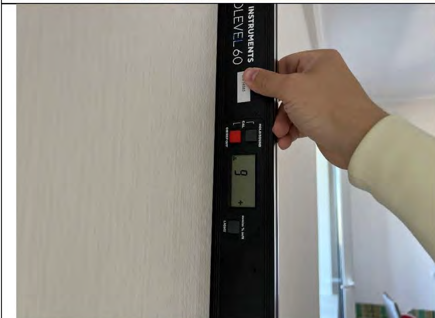
Фото №11. Измерение уровня стен в кухне.
